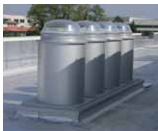
Réhausse cheminée cylindrique pour solin rond avec rébord (Ecole de Massalengo 2009)
