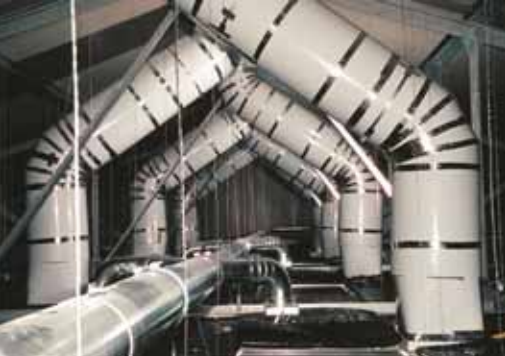
N. 14 SOLARSPOT 650, avec une configuration très complexe composée de 22 sections tubulaires, éclairent la surface de 560 m 2 de l'agrandissement de l'établissement FRE.TOR, Puos d'Alpago (Belluno) Italie (2001).
